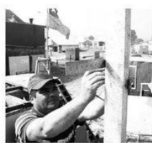
AÚN ESPERAN RECONSTRUCCIÓN.
