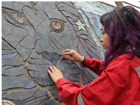
Artepista: construcción de mural de mosaico en avenida Matta.
